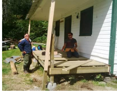
Marcel et François – Rénovant le chalet du 1 Mile – Renovating the 1 Mile camp
